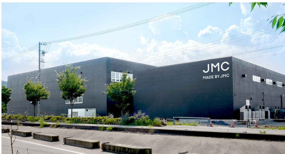
大型産業用 CT を設置する工場
